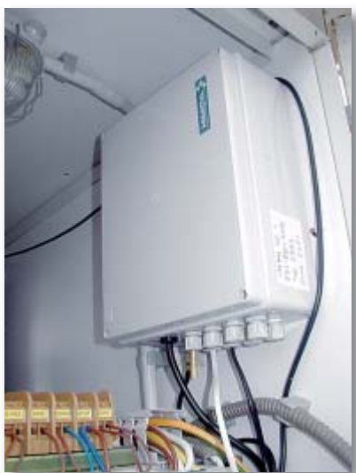
Odašiljači i Veze d.o.o. koriste TELECONTROL T45GSM za nadzor ispravnosti i dojavu kvarova na RTV objektima.
