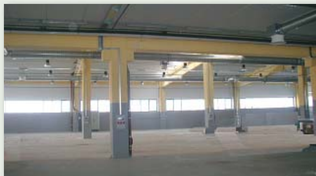
Pogon prije postavljanja strojeva
