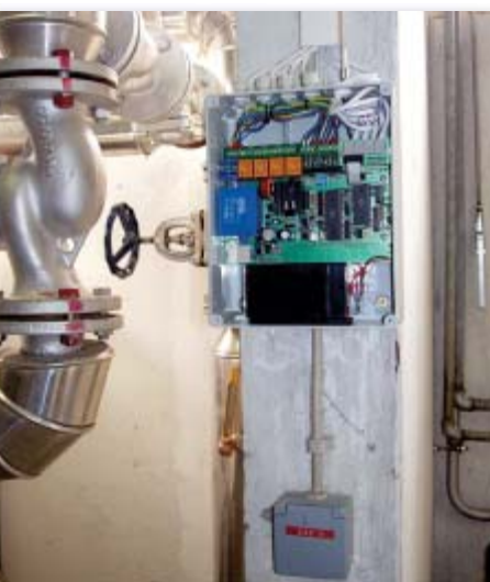
Stambeni servis d.o.o. koriste nadzorne uređaje TELECONTROL za nadzor kritičnih parametara unutar plinskih i inih kotlovnica
